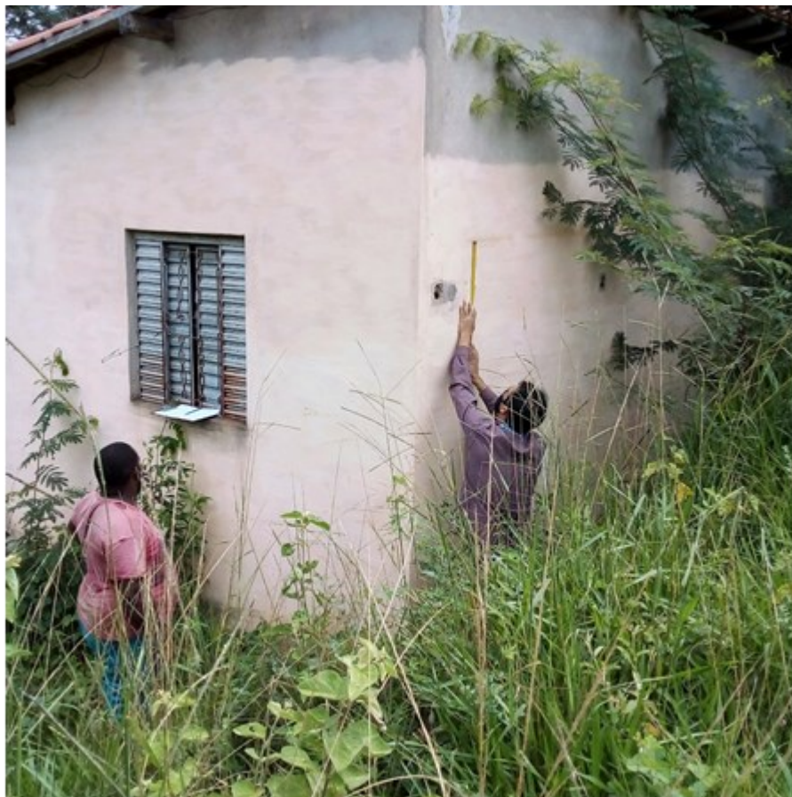
Figura 14: Altura da coluna de água em uma das edificações atingidas pelas cheias do rio Paraopeba nas comunidades rurais de Florestal, Minas Gerais.
